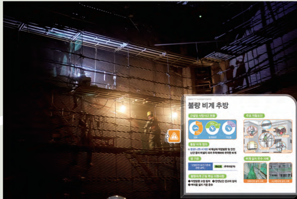
보일러 내부 비계작업
